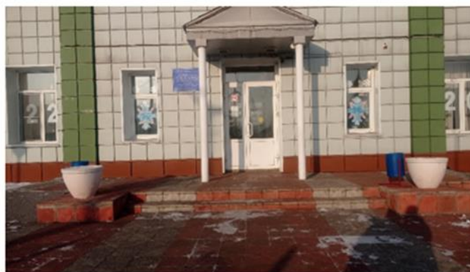
Фото № 14: Входная площадка (2 корпус)
