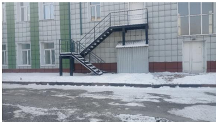
Фото № 7: Лестница (наружная) (2 корпус)
