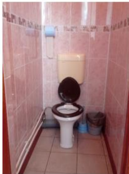
Фото № 32: Туалетная комната (1 корпус)
