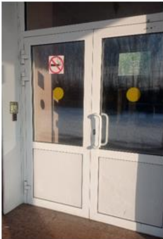
Фото № 17: Двери входные (1 корпус)
