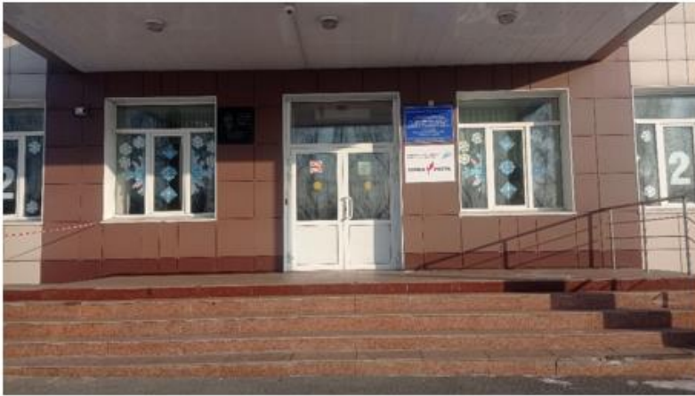
Фото № 15: Входная площадка (1 корпус)
