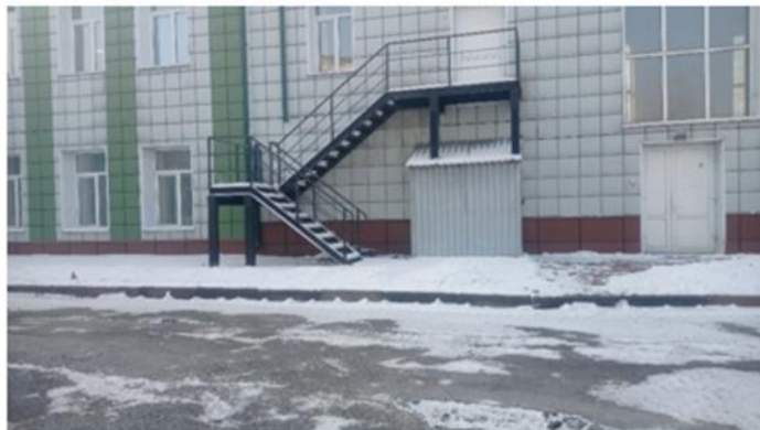
Фото № 11: Лестница (наружная) (2 корпус)
